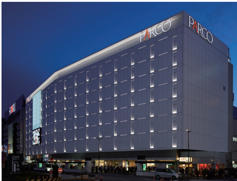
池袋パルコ外壁改修工事
