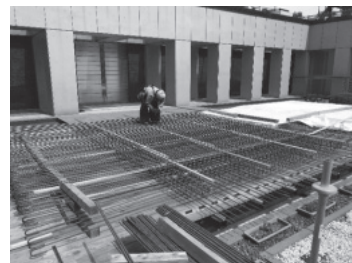
鉄筋地組み
