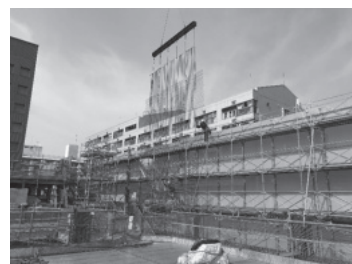
地組み鉄筋吊り込み
