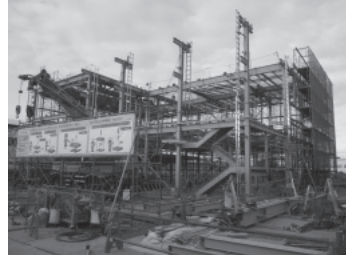
図4 施工計画モデルと実施工状況
