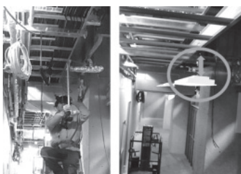
実施状況 モデル投影状況 照明器具懐スペース確認
