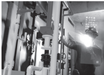
水圧試験実施箇所を現地で見える化
