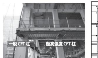
図9 超高強度CFT柱 (600mm角) と一般CFT柱 (1000mm角)
