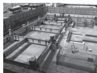
写真4 基礎工事状況
