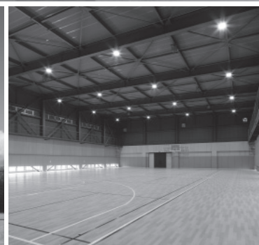
摂南大学農学部棟等新築工事
