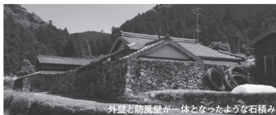
外壁と防風壁が一体となったような石積み
