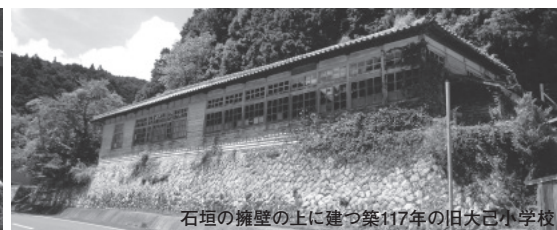
石垣の擁壁の上に建つ築117年の旧大己小学校
