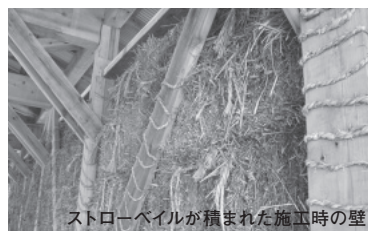
ストローベイルが積まれた施工時の壁
