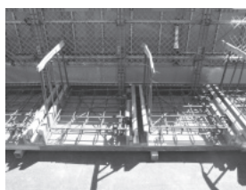
PCa材（コンクリート打設前）
