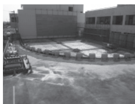
PCa材（設置後全景）
