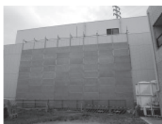
防音パネル取付後全景
