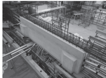
写真5 基礎大梁のPC化
