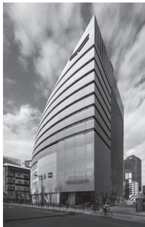
写真1 全体竣工写真
