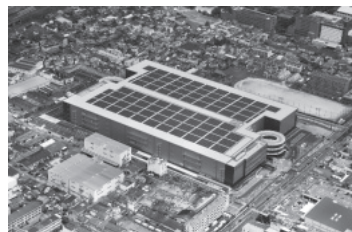
写真4 全体竣工写真
