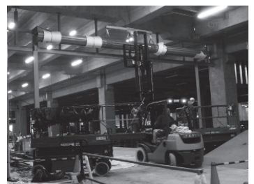
写真8 シャッターユニット現場付付
