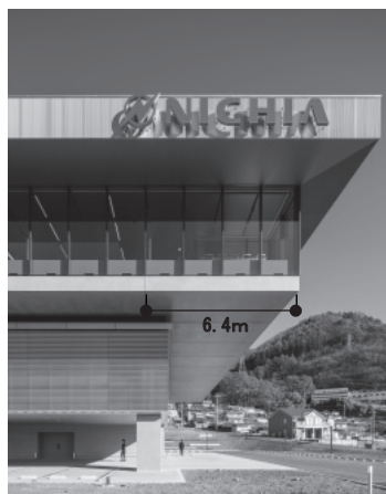
写真2 6.4m跳出し見上げ
