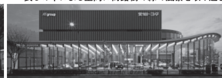
大通りに面した間口140mのカーモール
