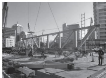
写真1 トラス鉄骨 地組み立て起こし状況
