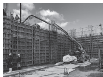
コンクリート打設状況
