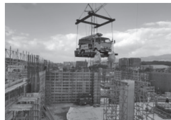
2tポンプ揚重状況
