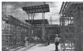
型枠支保工のユニット化(1)
