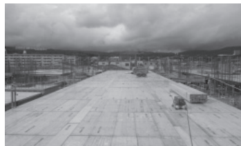
型枠支保工のユニット化(2)
