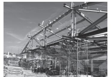
写3 3Dトラス屋根の鉄骨建方状況
