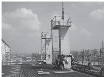
図2 柱躯体のプレキャスト化
