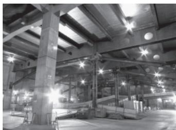
写真3 仮設スロープ設置状況
