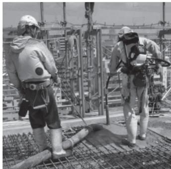
写真2 バックバック式エンジンバイブレータ使用状況
