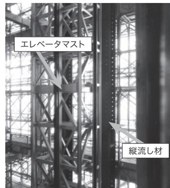
写真1 縦流し材設置状況
