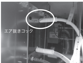
写真1 FCFUエア抜きコック
