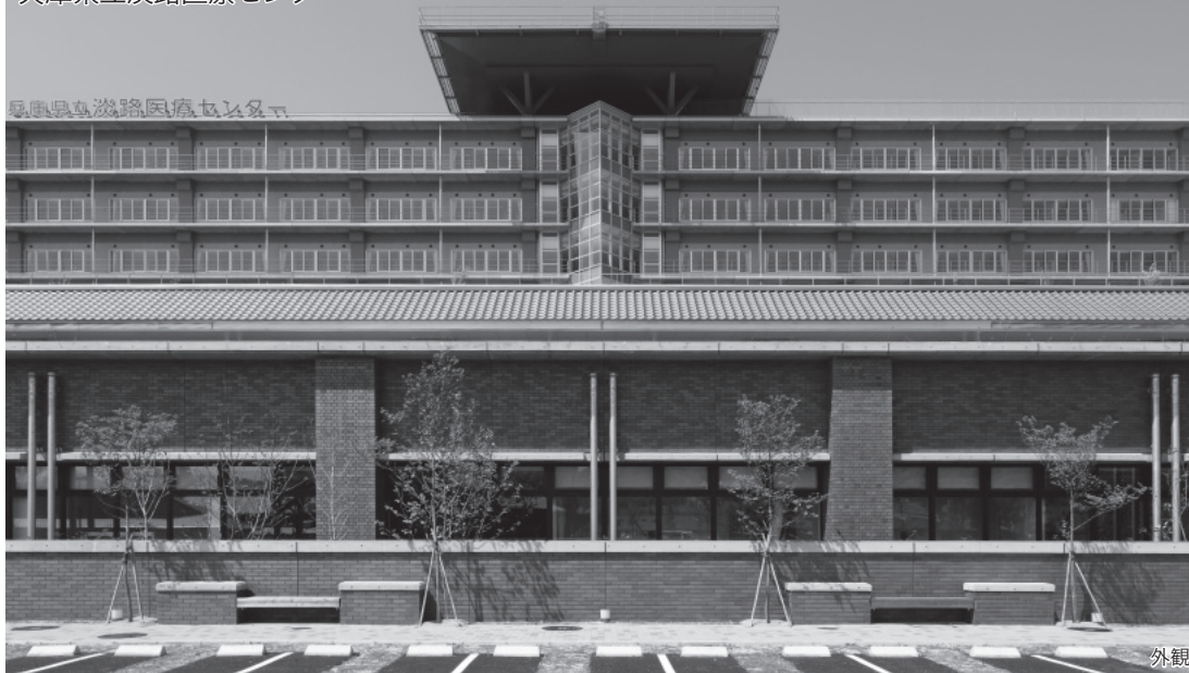
兵庫県立淡路医療センター
