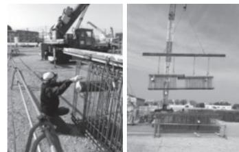
図4 地組スリーブ取付け状況
