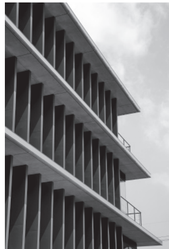
▲外周鉄骨細柱
