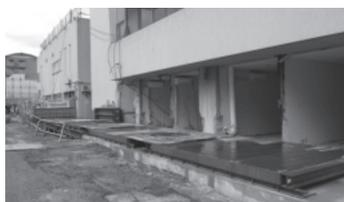
写真-1 作業構台架設状況
