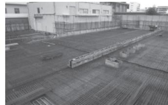
写真-5 補強スラブ施工状況
