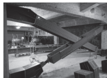
仮設ブレース
