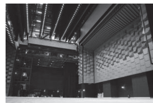
舞台と音響反射板(格納時)
