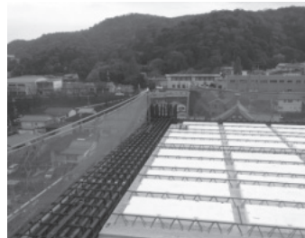
外周垂直ネット養生状況
