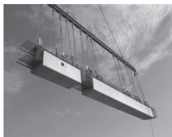
梁PC先行仕込状況
