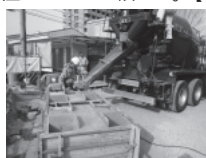
モックアップによるグラウト・コンクリートの充填試験
