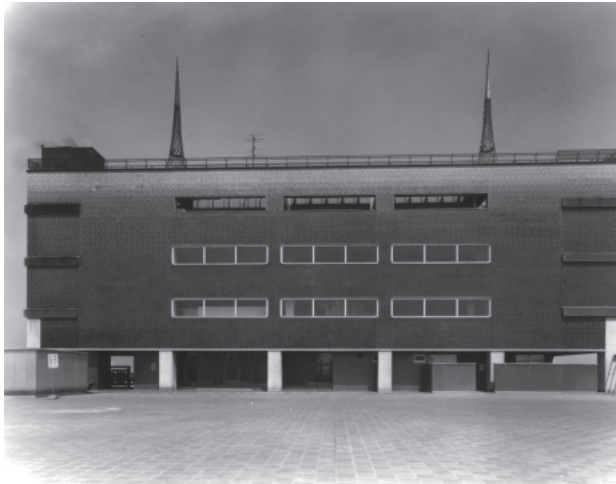
③屋上塔屋（竣工当時／撮影：多比良敏雄）
