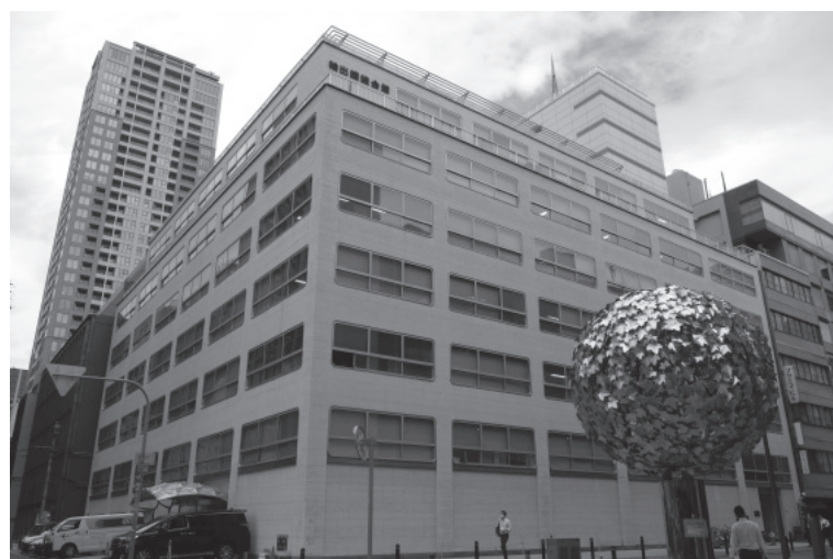
①南西から見る（現状／筆者撮影）
