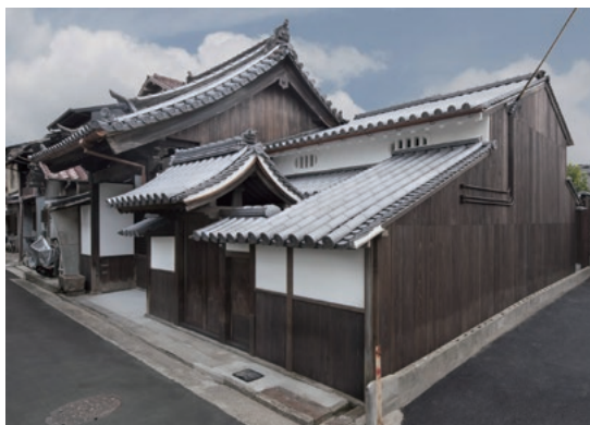
清学院（浜六間筋からみる不動堂・庫裏・門）
