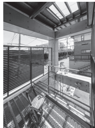
RCの柱梁と木屋根に抱かれるテラス
