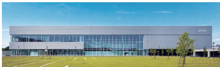
建物正面（中央部が吹抜空間）
