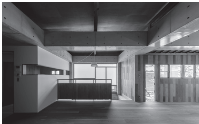
RCフレームに木の屋根と造作が差し込まれ、ひとつながりに広がる内部空間
