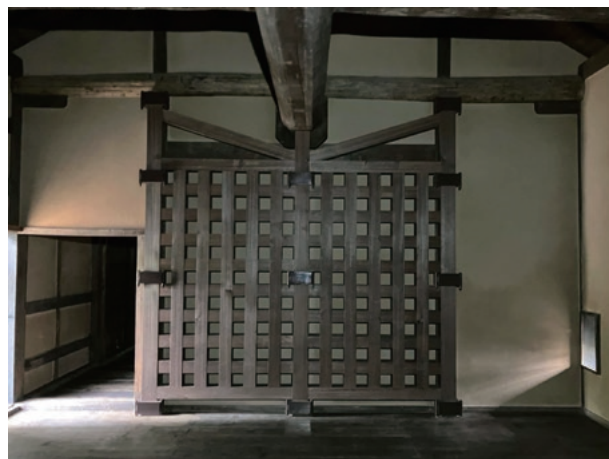
監物櫓の木造格子壁による耐震補強
