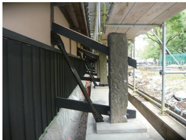
長堀のステンレス筋かいとコンクリート基礎による耐震補強
