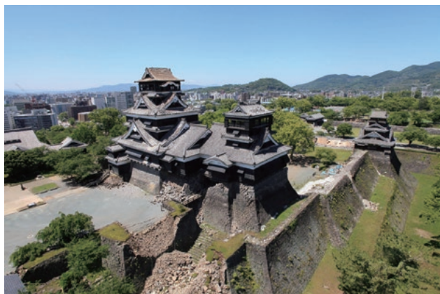
平成28年熊本地震 被災直後の天守閣
