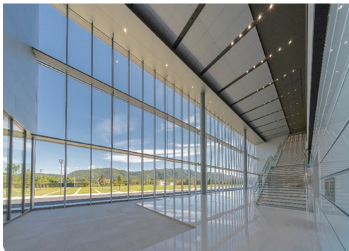
吹抜空間（2段のPL状の部材が耐風梁）
