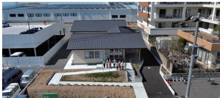
新しい高倉台地域会館（2025年9月竣工）
