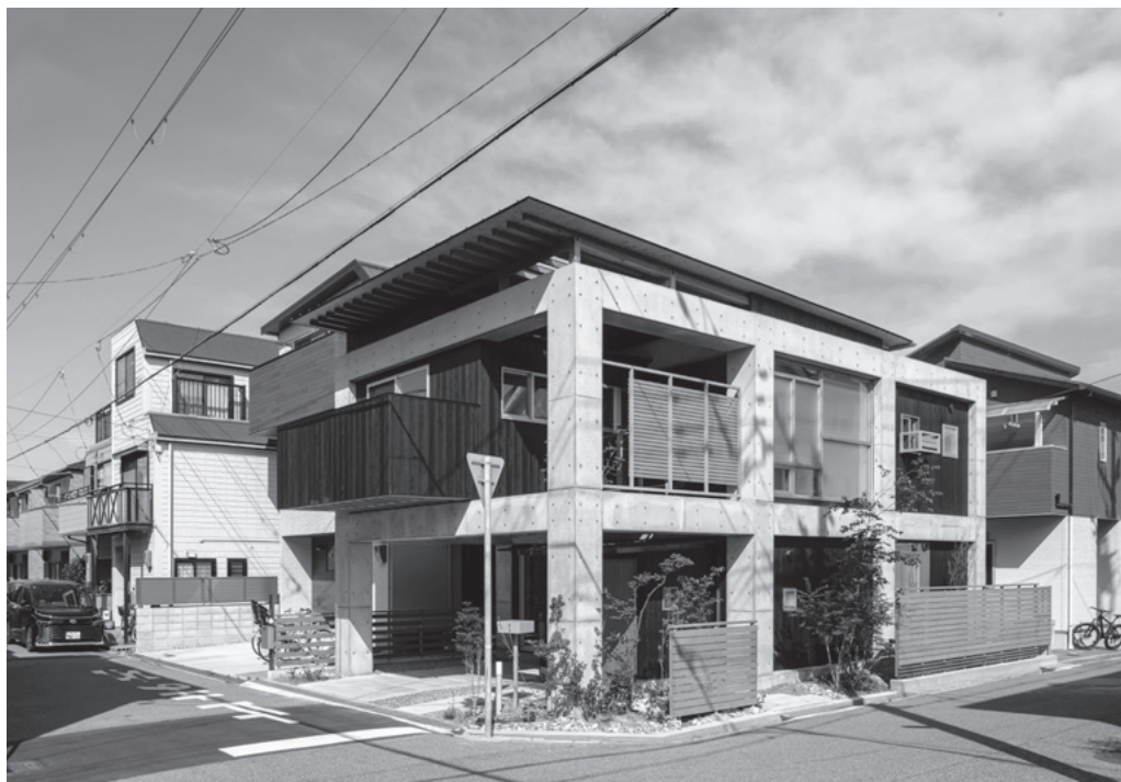
敷地は角地にあり、小さな庭、コンクリートと木の層が重なる
